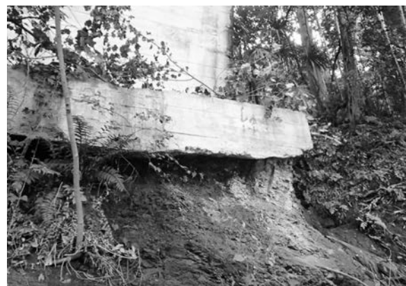
写真-2 P4アーチアバットの浸食
