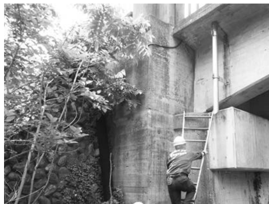
写真-7 他の橋の技術相談の例(2)
