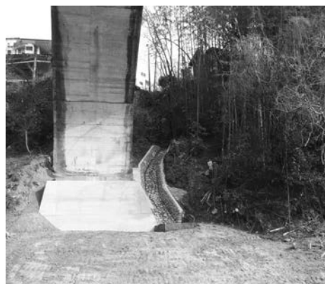
写真-8 下部補修工事（浸食対策工）の成果（R4.3）
