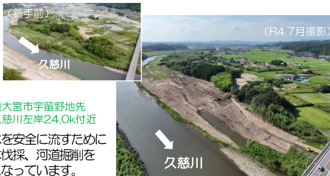
R3久慈川左岸宇留野地先河道掘削工事/珂北開発株
