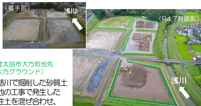
R3久慈川土砂改良(その1)工事/榊原建設
