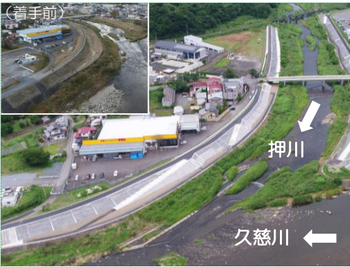
R2久慈川右岸大子地先下流築堤護岸(その2)工事 (株式会社吉田組)
