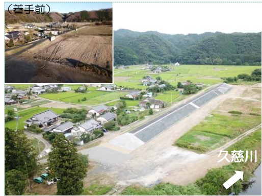
R2久慈川左岸西野内地先築堤護岸工事 (株式会社秋山工務店)
