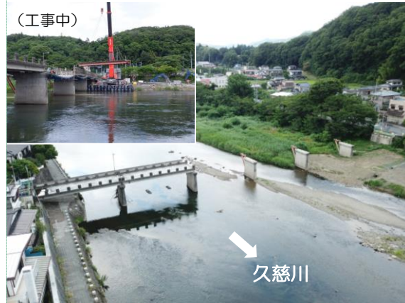
R2久慈川左岸西野内地先築堤護岸工事 (松沼橋上部工撤去) (株式会社秋山工務店)
