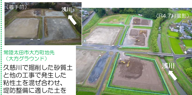
R3久慈川土砂改良(その1)工事 / 榊原建設
