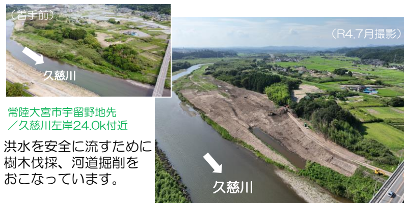
R3久慈川左岸宇留野地先河道掘削工事 / 珂北開発(株)
