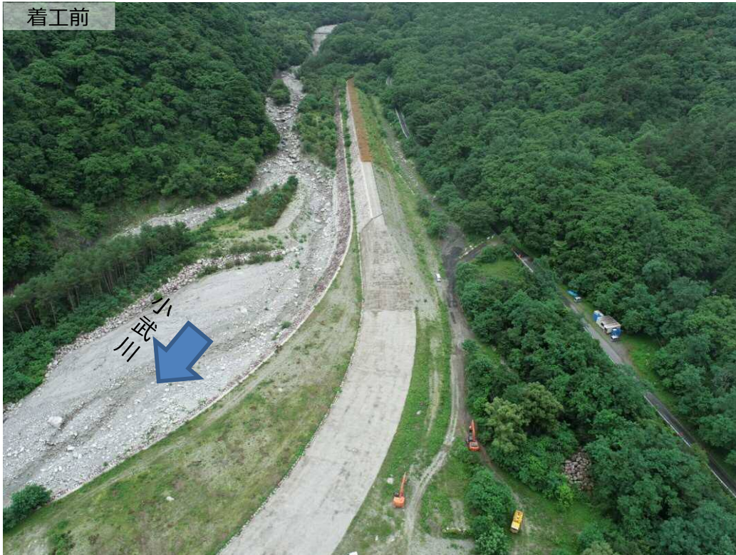
下流側より上流撮影
