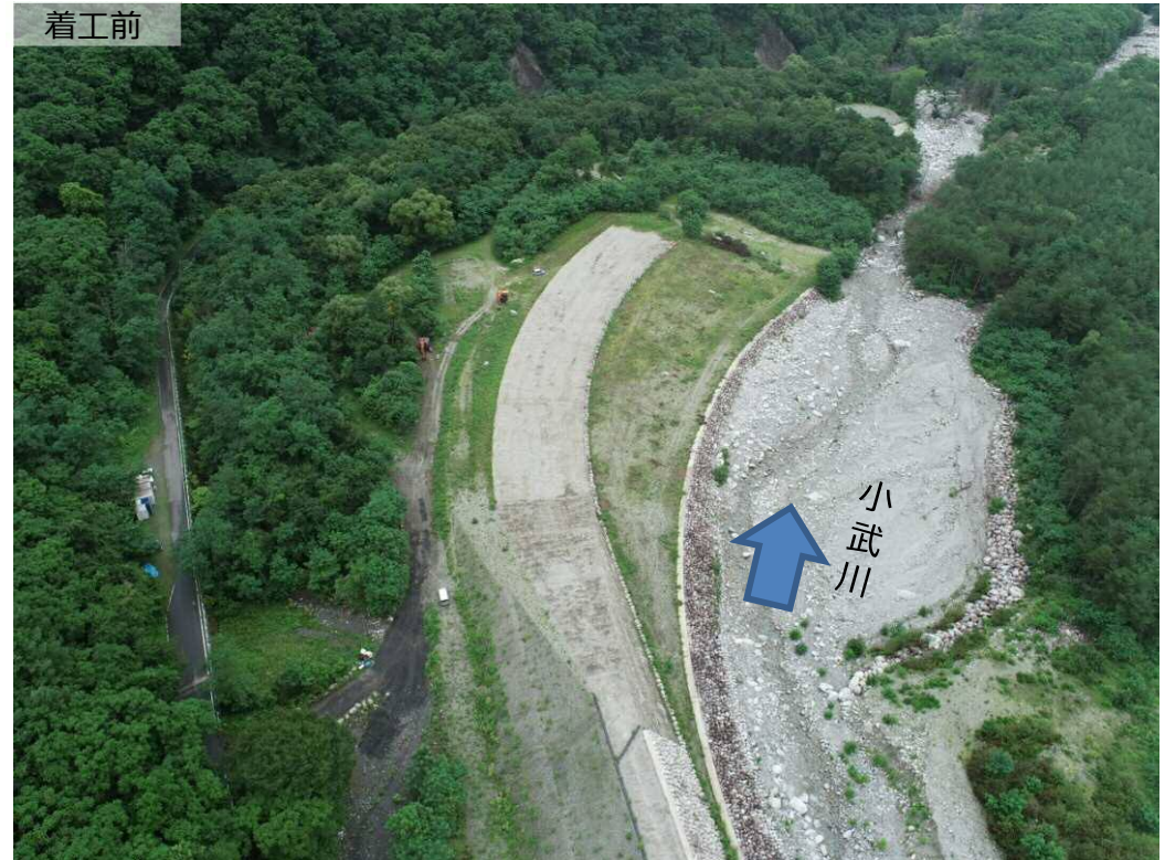
上流側より下流撮影
