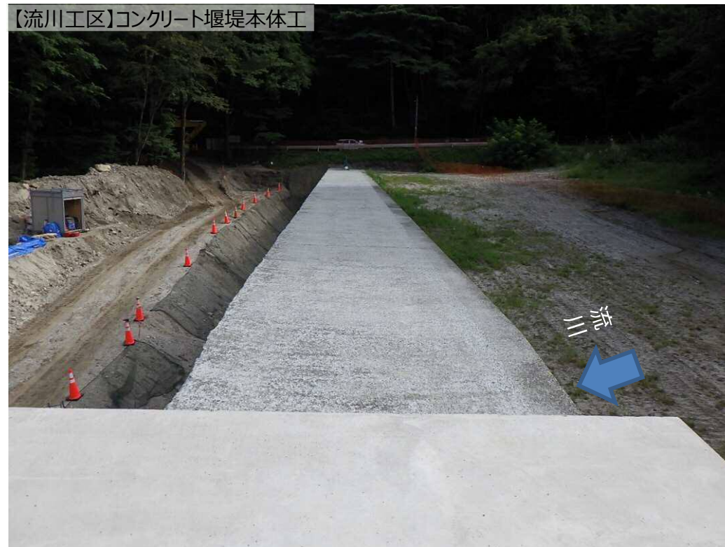
右岸側近景撮影
