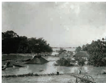
川辺村(現・加須市)の浸水状況
