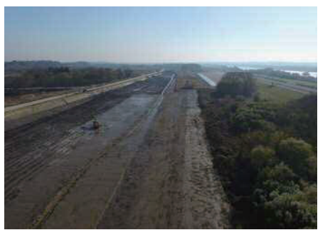
▲稲戸井調節池の掘削状況
