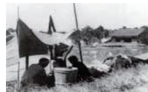
【向古河(現・加須市)付近堤防上避難状況】
