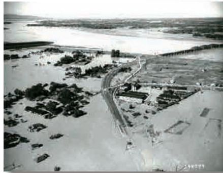
JR宇都宮線の浸水状況
