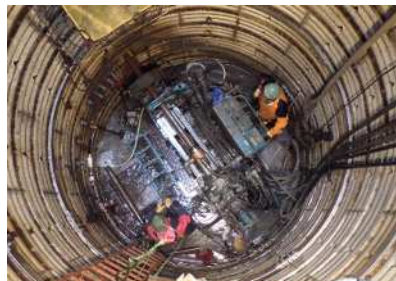
集水井(集水Bo)施工状況(R4.6.17)
