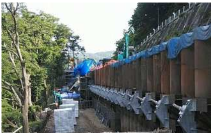
アンカー工(川側)施工完了(R4.6.15)
