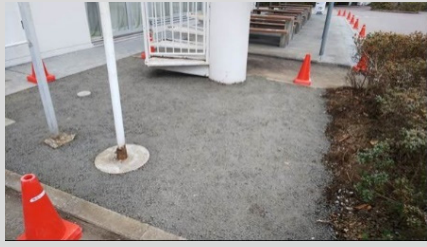
② 回収骨材・回収水を用いたポーラスコンクリートの施工状況（大学構内）
