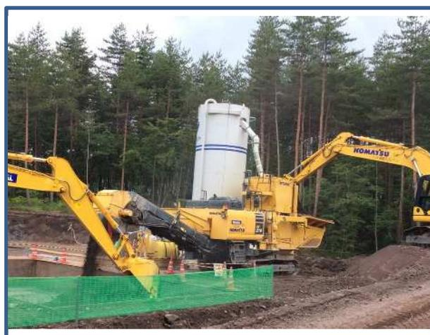
砂防ソイルセメント(攪拌・混合)施工状況
