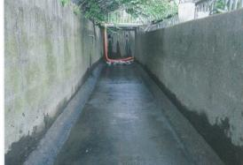
緊急浚渫推進事業債を利用し、河川や幹線水路等の浚渫を実施している。これにより土砂が堆積し流下能力が低下した河川や水路の機能回復が図られるとともに、河道内貯留の効果も期待され、浸水被害の軽減に寄与。
