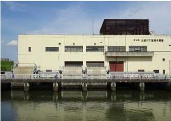
中川流域における浸水被害軽減のため、大場川の洪水を江戸川に排水するための大場川下流排水機場の増強を実施。令和3年度末に完了予定。
