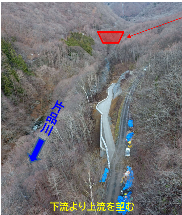
片品上流第二砂防堰堤
