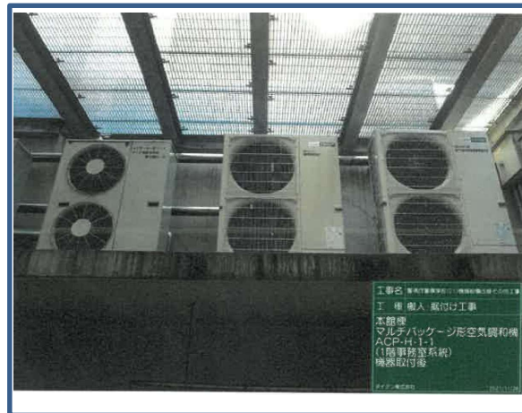
室外機 設置完了
