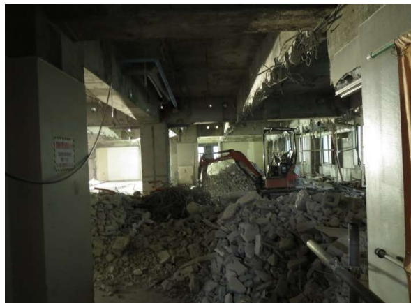
拘留室の隔壁解体状況
