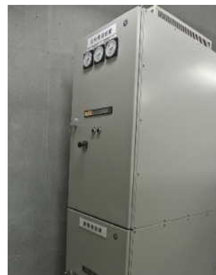
【直流電源装置 (更新箇所)】
