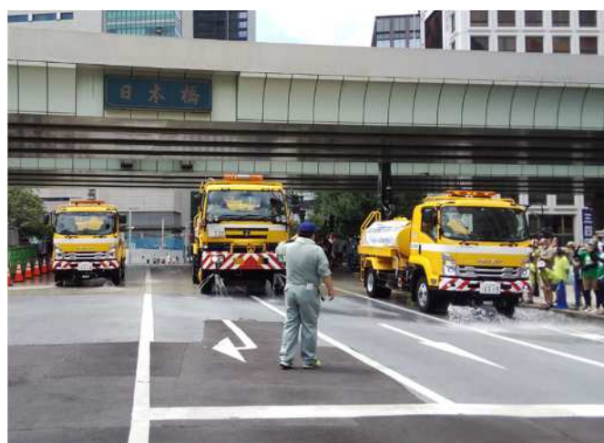
橋洗い、散水車(3台)による洗浄です 今年も再生水で実施しました
