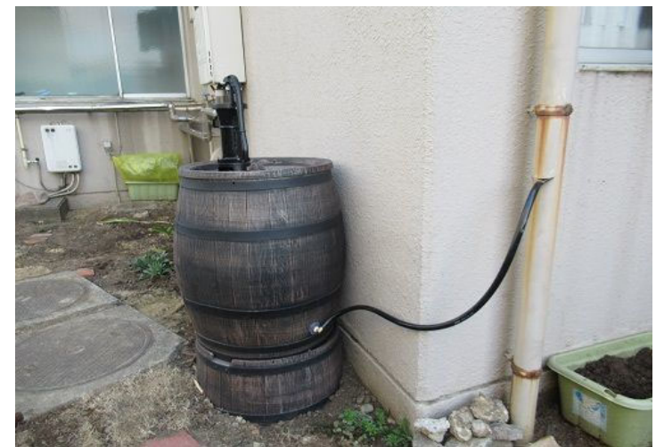
雨水貯留タンク設置
