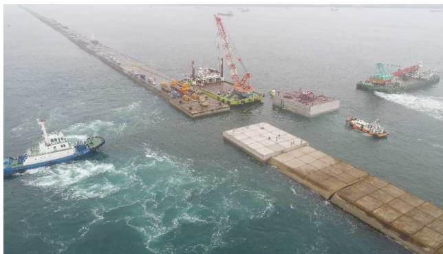
ケーソン据付状況
