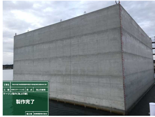
ケーソン製作完成
