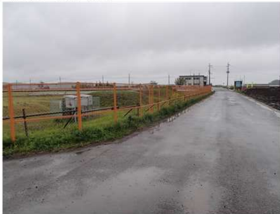
完成又は施工状況写真
