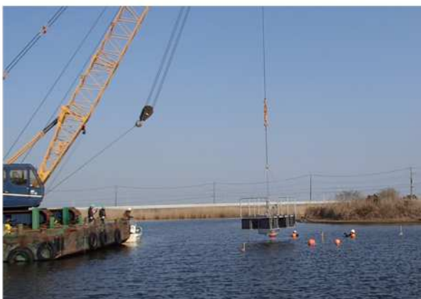
ポンプ台船の設置(霞ヶ浦樋管)
