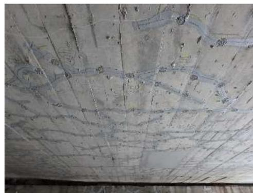
ひび割れ補修工(完成)
