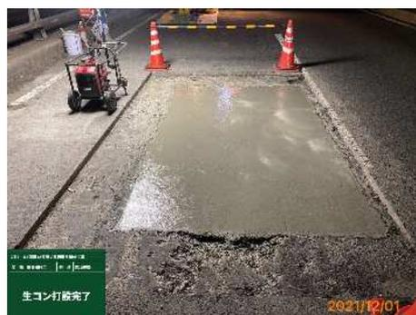
床板補修(ジェットコン打設)
