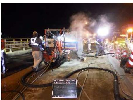
床板損傷箇所の取り壊し作業
