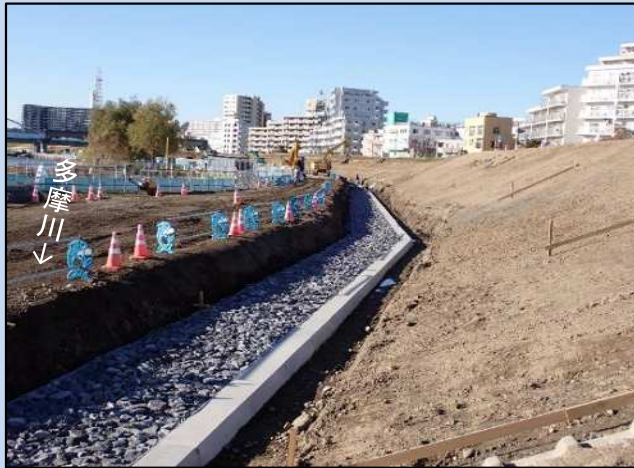
護岸を施工しています。 (令和4年12月)
