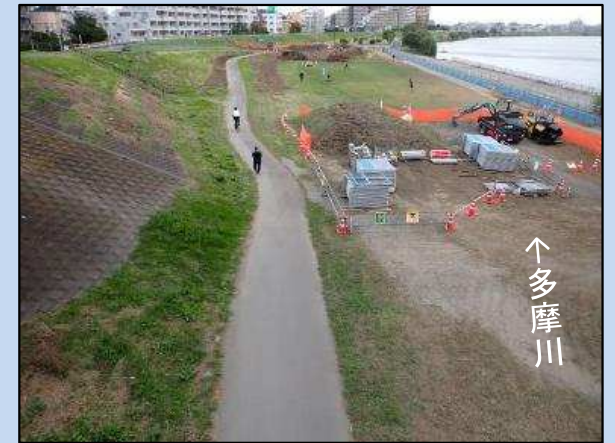
工事に入る準備をしています。 (令和4年10月)
