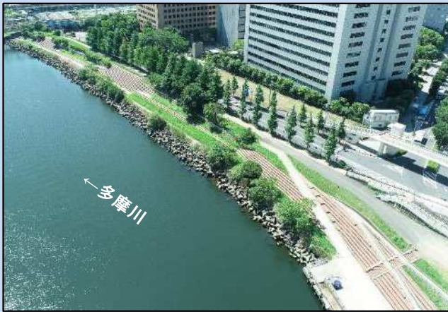
(令和4年8月) 工事着手前
