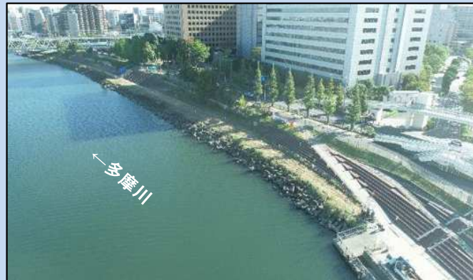
工事に入る準備をしています。 (令和4年10月)
