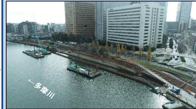
護岸を施工しています。 (令和4年12月)
