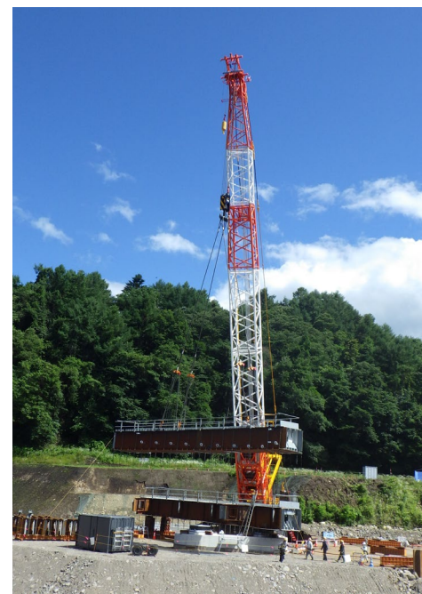
施工状況②
