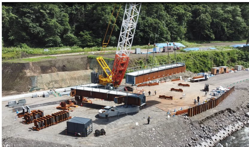
施工状況①
