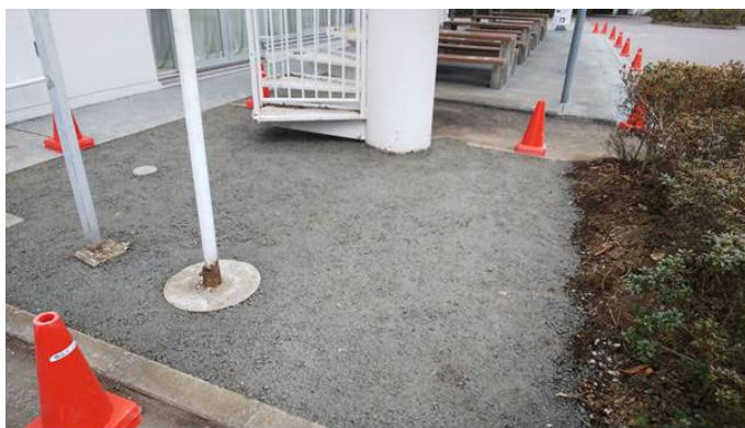
写真2 回収骨材・回収水を用いたポーラスコンクリート
