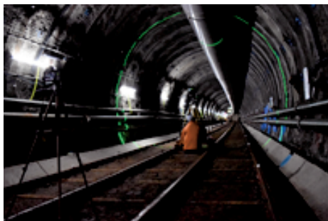
実トンネル計測の様子
