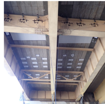
写真 1 計測対象の RC 床版
