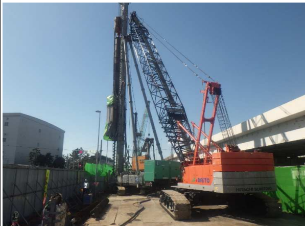
既製杭施工状況
