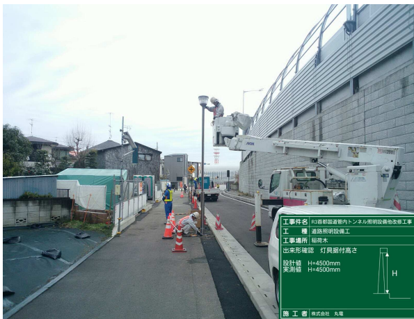
歩道照明施工状況(稲荷木地区)
