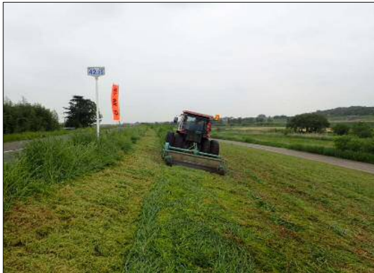
除草施工状況
