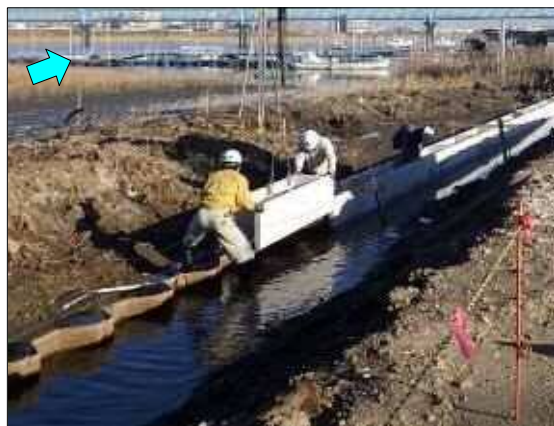
プレキャスト笠コン施工状況
