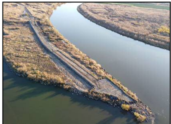
管理用道路(江戸川流頭部)修繕状況
