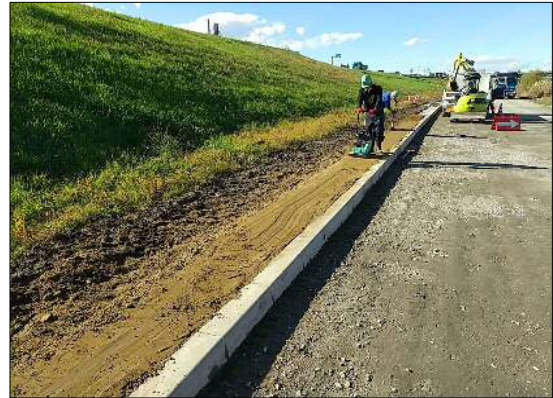
管理用道路修繕状況
