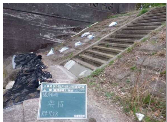
応急対策(護岸補修_完成)
