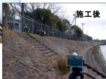
支障物撤去(樹木伐採)
