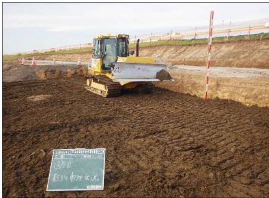
盛土施工状況
