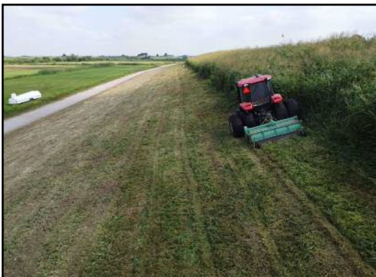
除草施工状況
