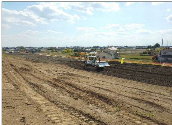
盛土施工状況
