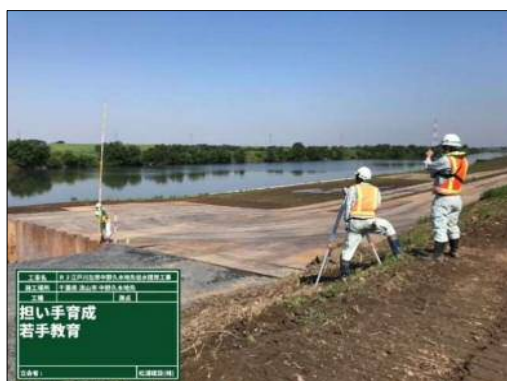
若手技術者への研修(測量作業)
