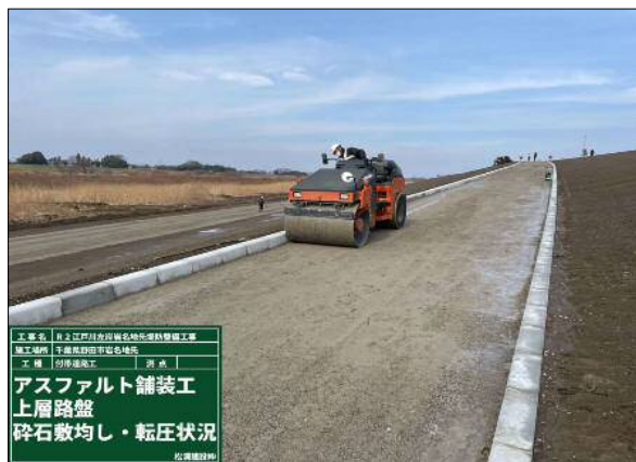
坂路施工状況
