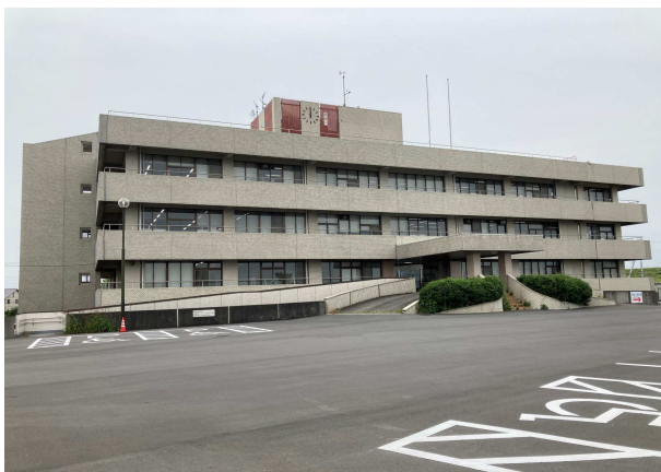
庁舎南側外観
