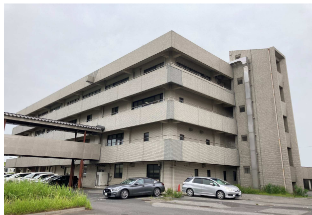
庁舎北西側外観
