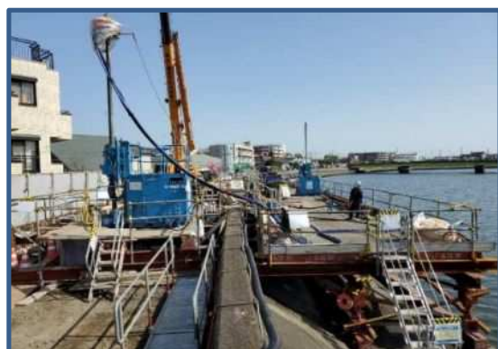
高圧噴射攪拌施工状況
