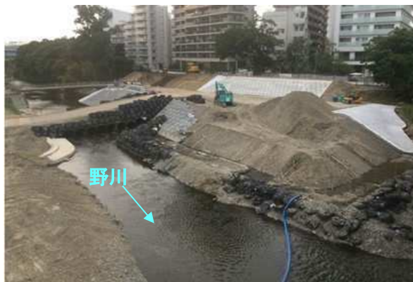
築堤・低水護岸施工状況
