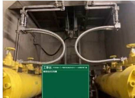
油圧シリンダ配管整備後
