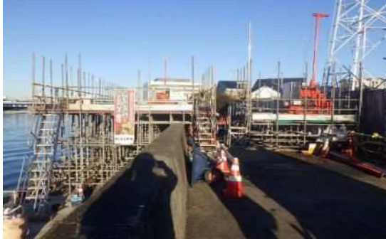
高圧噴射攪拌(排泥式)施工状況
