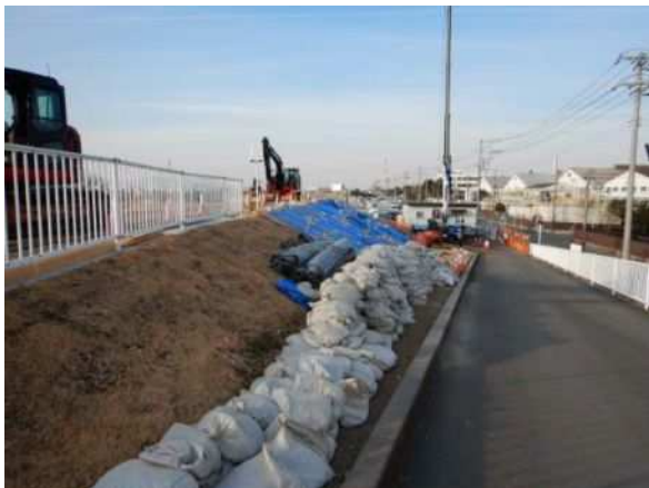
法崩れが発生した堤防の本復旧施工状況
