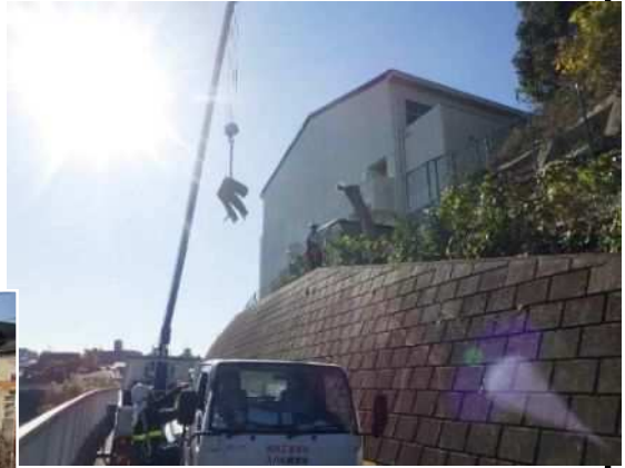
伐採施工状況
