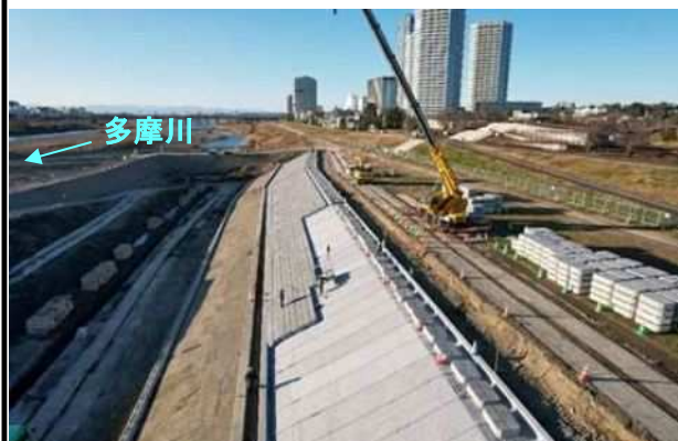
接続ブロック施工状況
