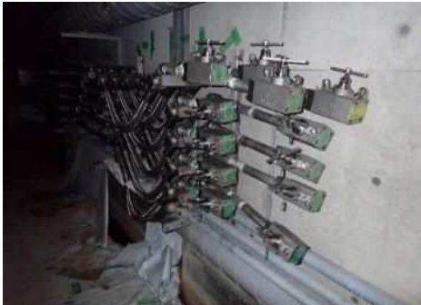
監査廊内整備状況
