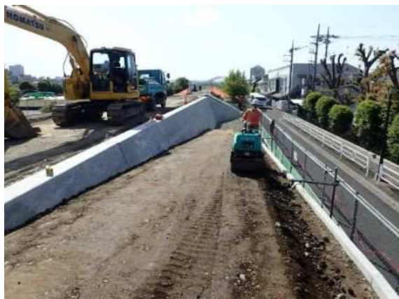
坂路施工状況
