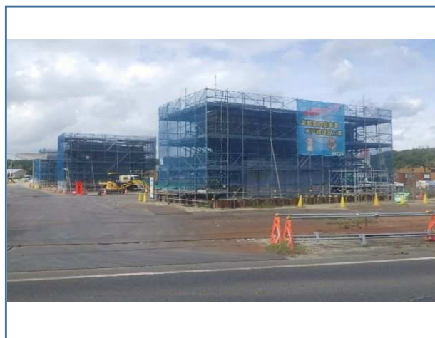
下部工施工状況
