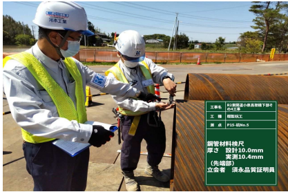
材料検査状況
