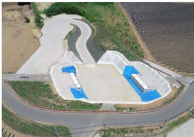
小幡地先 完成
