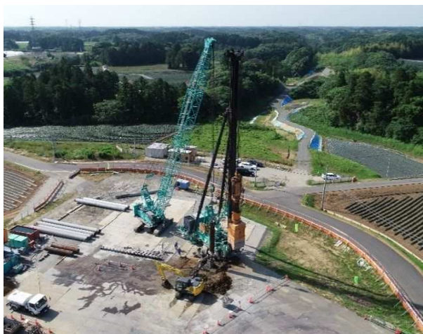
既製杭施工状況
