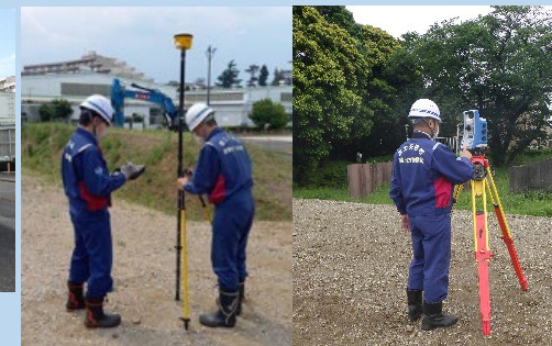
3次元計測機器による出来形計測実習
