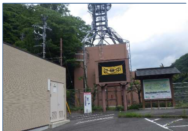
【五十里ダム放流警報表示板(更新箇所)】
