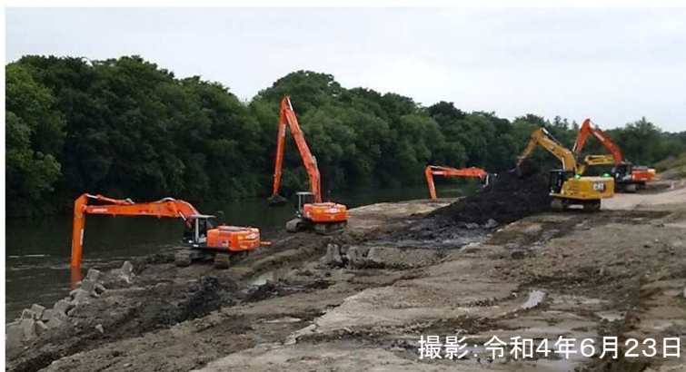
ロングアーム重機による崩落土砂の撤去状況
