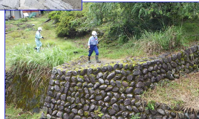
▲早川流域の点検状況
