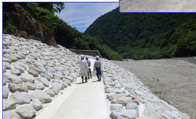
▲小武川流域の点検状況
