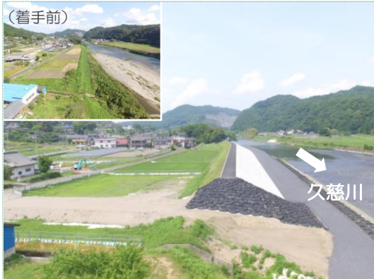
R2久慈川右岸舟生地先築堤護岸工事 (樋口土木株式会社)
