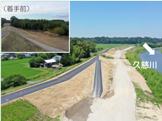
R2久慈川右岸岩崎地先河道掘削外工事 (小林建設株式会社)
