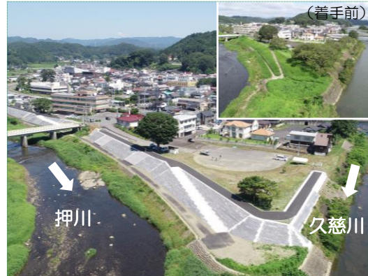
R2久慈川右岸大子地先上流築堤護岸工事 (北都建設工業株式会社)
