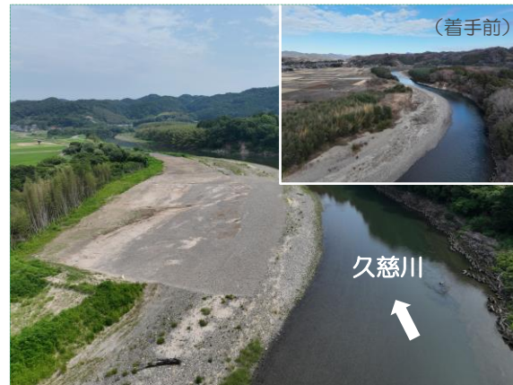
R2久慈川左岸小貫地先 河道掘削外（その1）工事 (株式会社梅原工務店)
