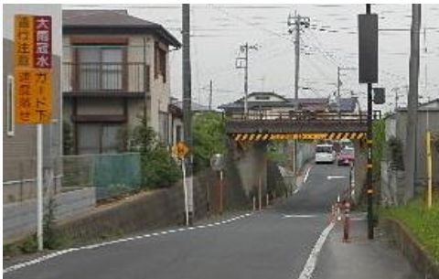
冠水前の状況 市道 11019号線 川間ガード下 (道路冠水箇所リストNo27)
