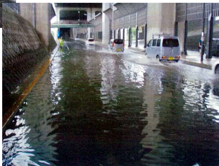
冠水状況（令和2年8月12日 集中豪雨） 国道298号 川口市神戸地先（本線） （道路冠水箇所リストNo. 259）
