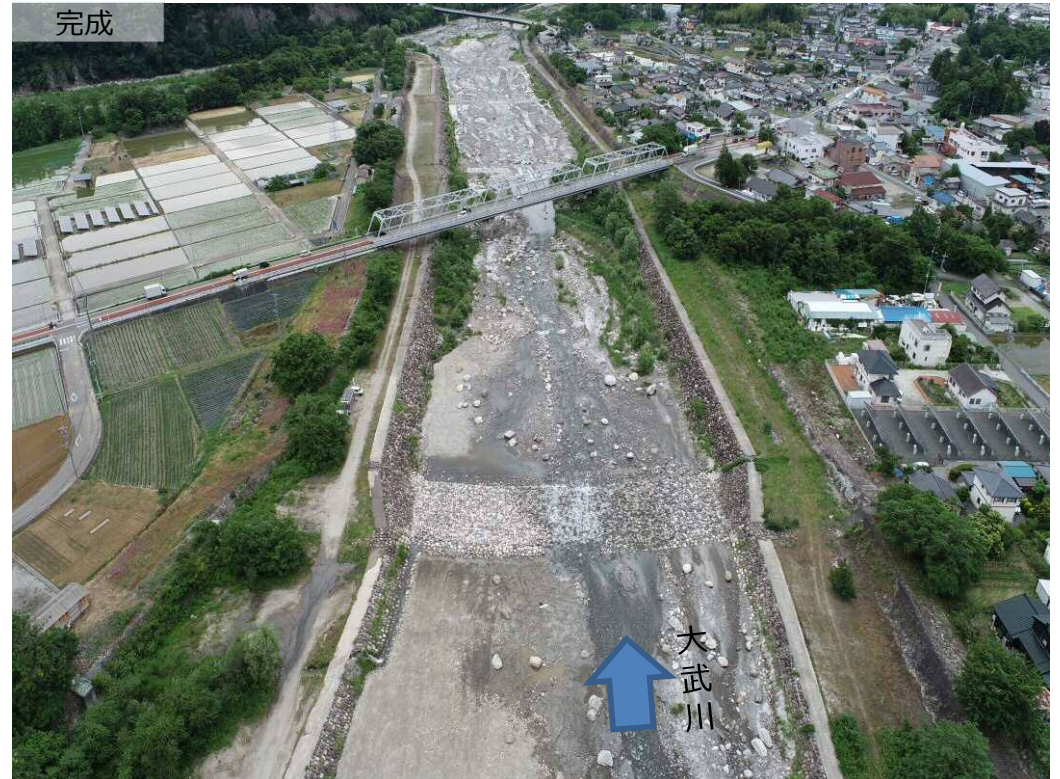
上流側より下流撮影
