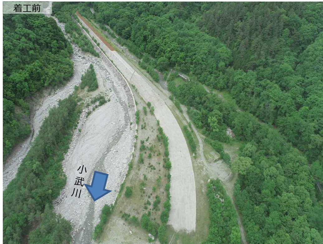
下流側より上流撮影
