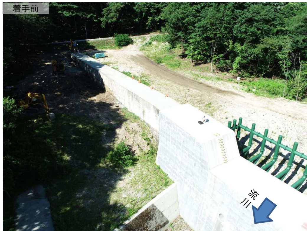
下流側より右岸撮影
