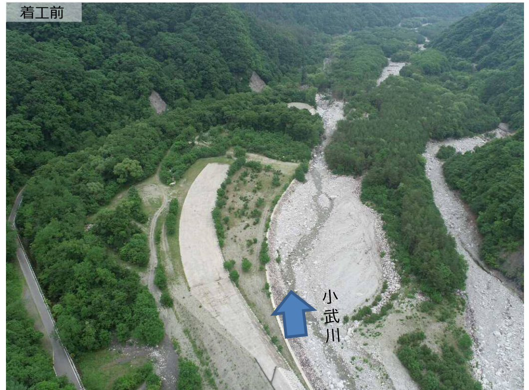
上流側より下流撮影
