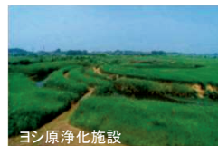
ヨシ原浄化施設
