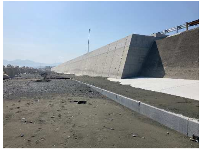
護岸擁壁(完成)
