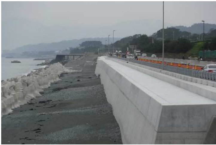
護岸擁壁(完成)
