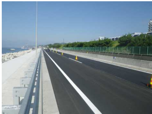
舗装復旧(現時点)
