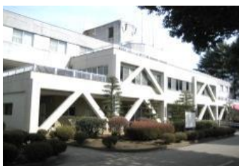
総合運動公園事務所(栃木県)
