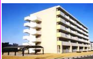
公営住宅整備事業(茨城県)
