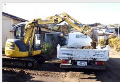
堆積土砂の撤去
