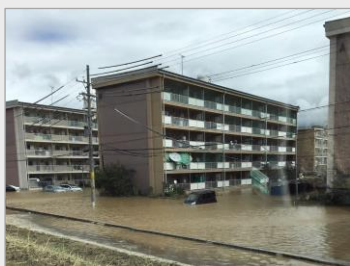
被災公営住宅の復旧に係る支援
