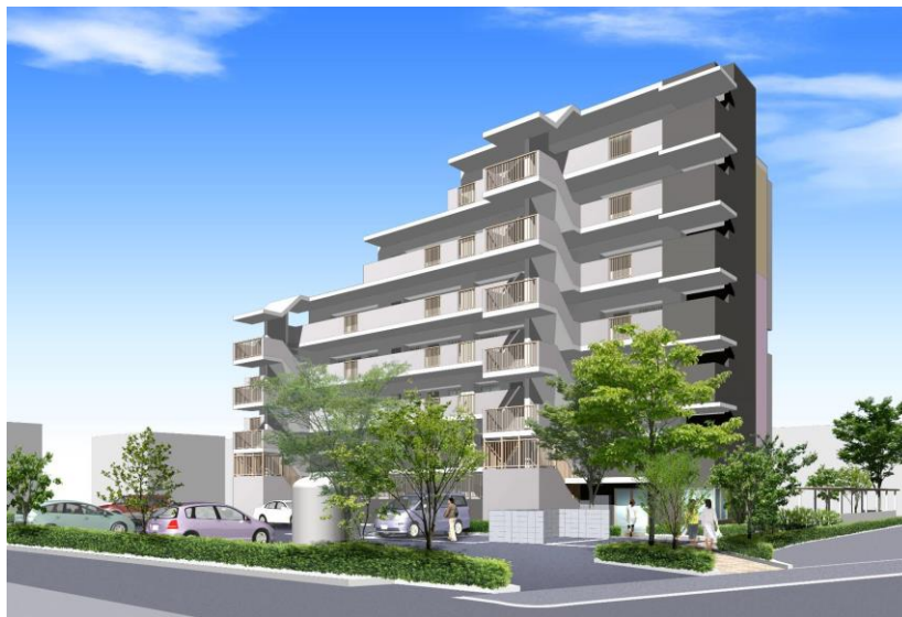
PFI手法により、子育て世帯等を対象とした地域優良賃貸住宅を整備・維持管理（神奈川県松田町）（2019年2月竣工）
