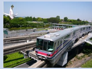
都市モノレール(大阪モノレール)
