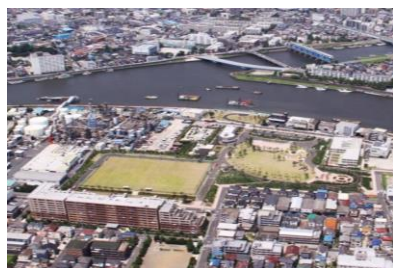
防災拠点避難地等として機能する都市公園
