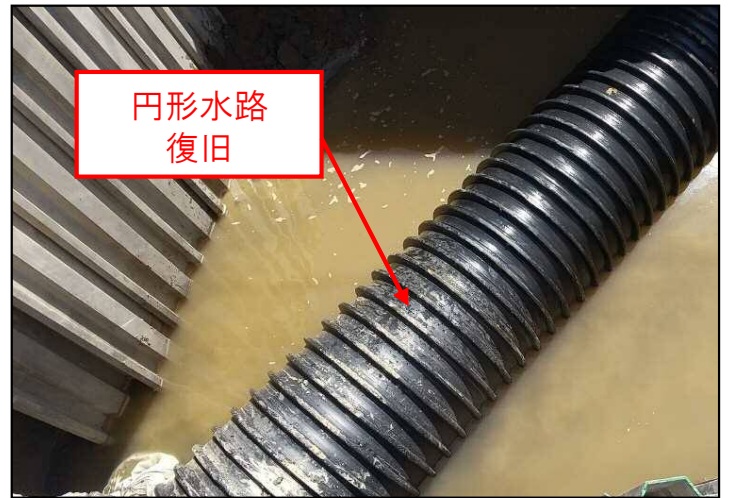
円形水路復旧完了時
