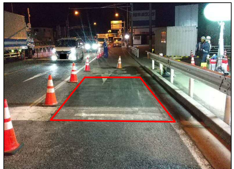
復旧（舗装）完了時
