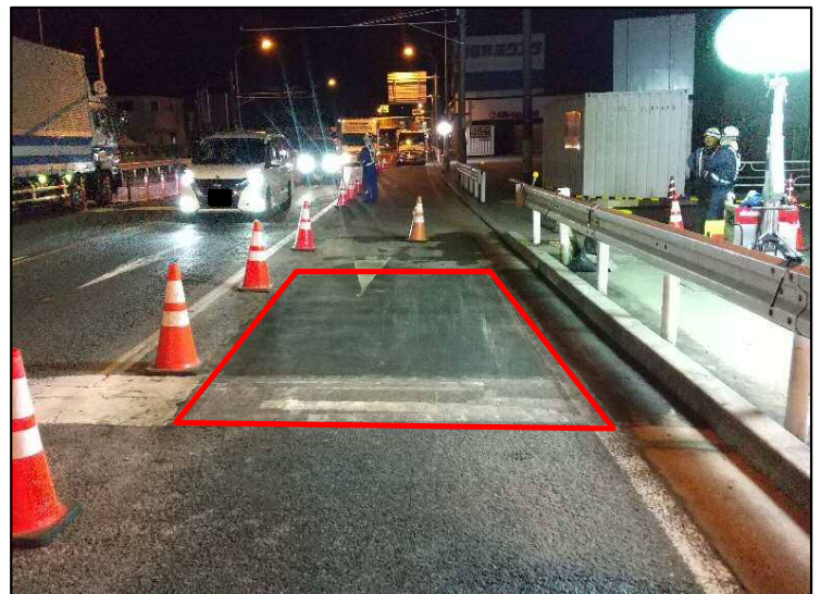
復旧(舗装)完了時
