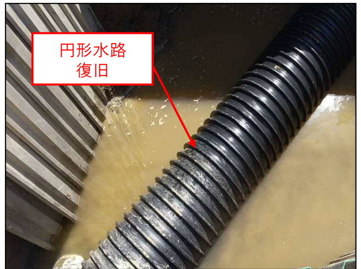
円形水路の復旧状況
