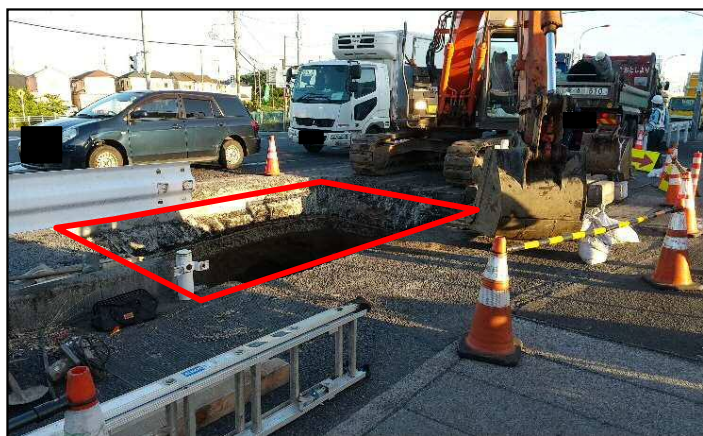
舗装版撤去完了時
