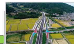
今福インターチェンジ付近
