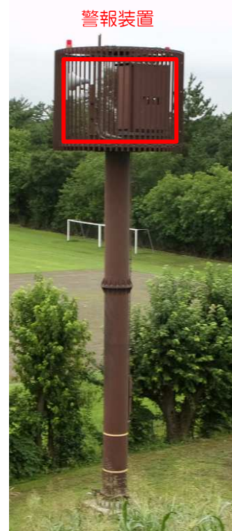
警報装置写真 ポール既設流用
