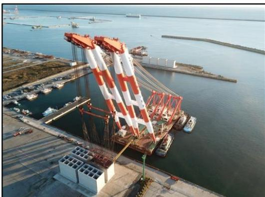
写真5 大型起重機船による吊上→
