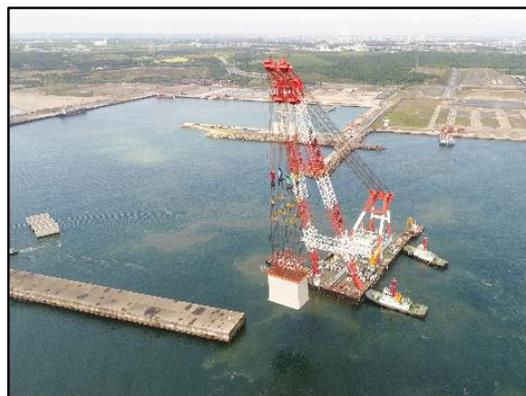
写真6 大型起重機船による吊上→
