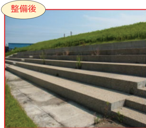
高水護岸（階段護岸）を整備
