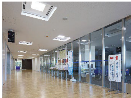
事務室出入口(自動扉の設置)
