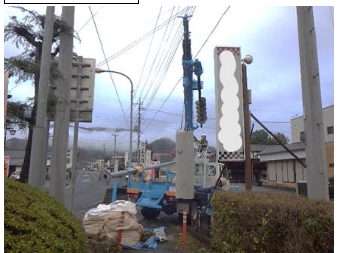
照明灯ポール立替
