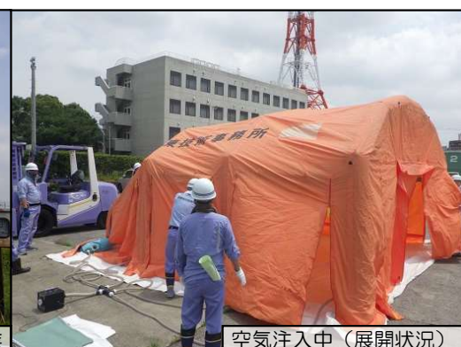
エアーテント設置訓練
