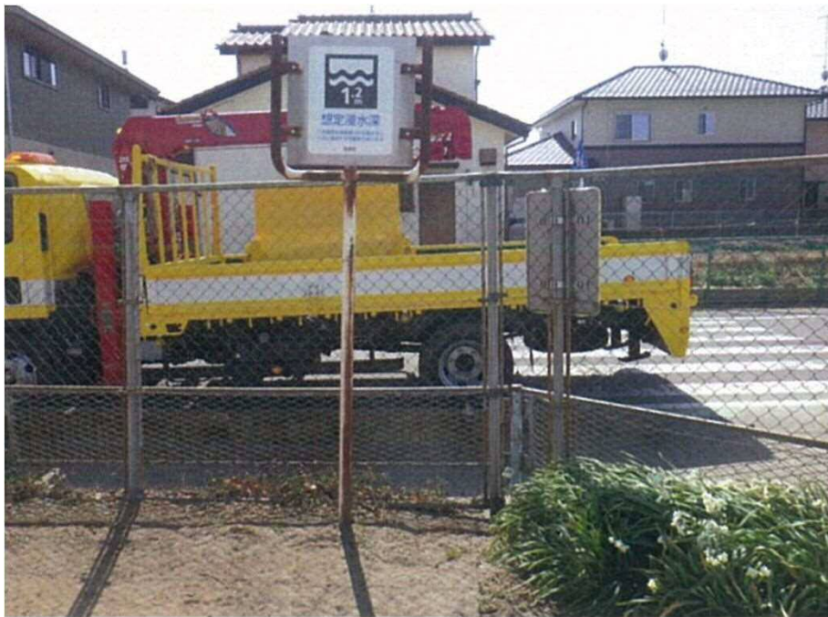
邑楽町立中野小学校の施工例
