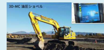
施工(ICT施工)
